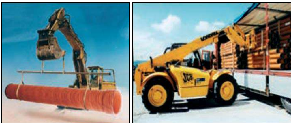
4 paveikslas. Mechanizuotas vamzdžių krovimas
